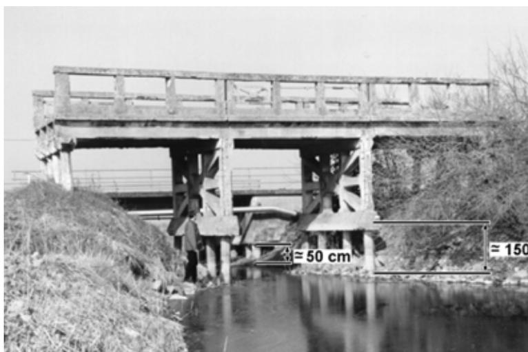
**Fig. 1.2:** Un ponte costruito negli anni '20 mostra una protusione della fondazione pari a 150 cm corrispondenti alla subsidenza avvenuta per compattazione in seguito all'ossidazione dei terreni torbosi e da pompaggi di acque sotterranee. Sullo sfondo il nuovo ponte, che risale agli anni '70, evidenzia l'abbassamento del suolo, di circa 30 cm, avvenuto negli ultimi trent'anni (fonte Consorzio di Bonifica Adige Bacchiglione).
