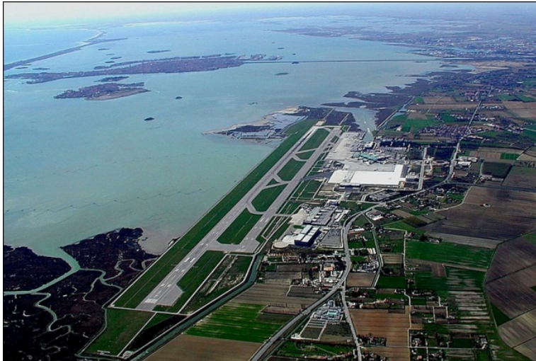
Figura 3-15 Vista aerea dell'aeroporto "Marco Polo".
