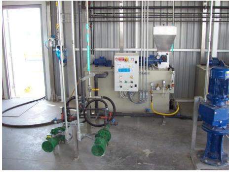
**PSE 1-2** N° 2 pompe centrifughe in ghisa, portata 30 mc/h a mt 10 motore a secco Kw 2.2.
