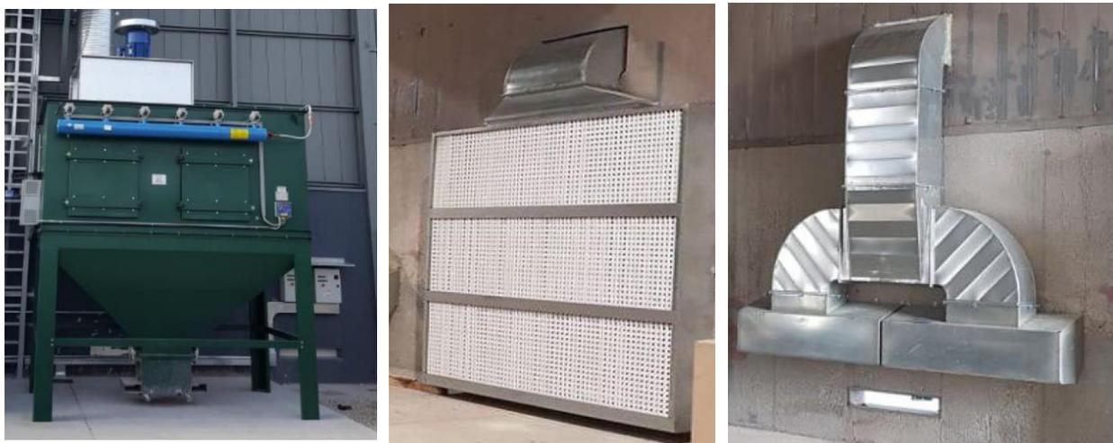
Figura 8 – Sistemi mobili di aspirazione previsti a servizio delle coperture mobili esistenti
