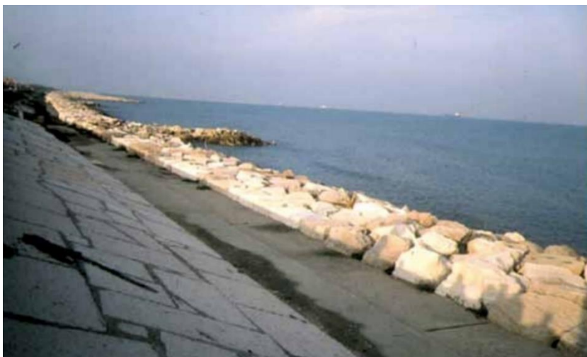
Figura 21 - I murazzi oggi, con la scogliera posta al piede e i piccoli pennelli dissipatori
