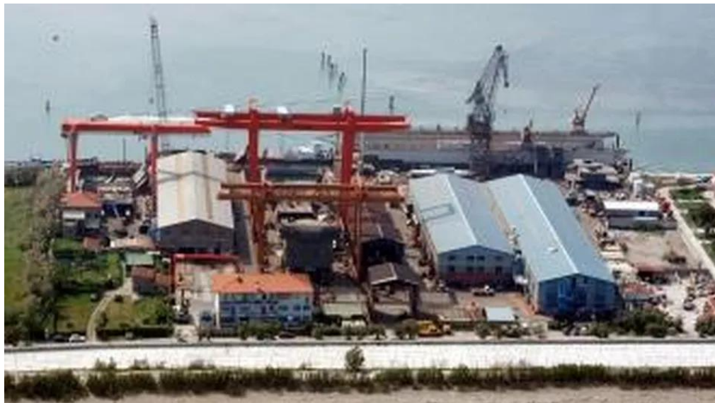
Figura 27 – Vista a volo d'uccello verso la laguna del cantiere durante la gestione De Poli (Fonte: La Nuova del 28.02.2011, immagine di repertorio)
