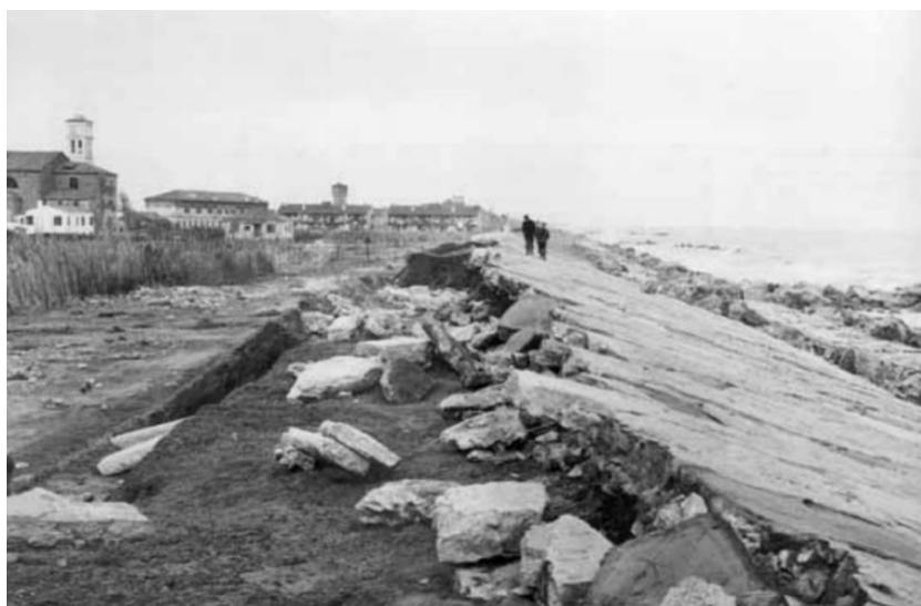
Figura 20 - Murazzo di Pellestrina danneggiato dalla forte mareggiata che si è accompagnata alla marea del 4 novembre 1966
