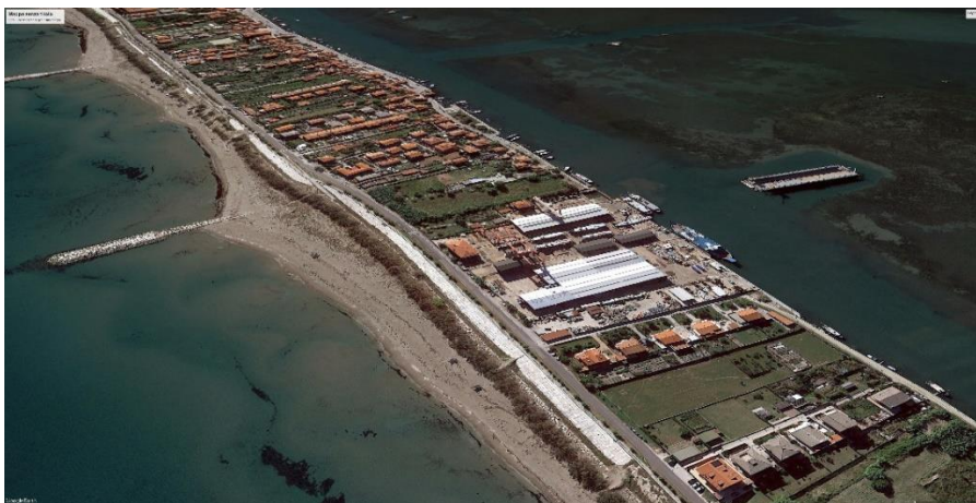
Figura 26 – Vista a volo d'uccello del cantiere durante la gestione De Poli (Fonte: Google Earth)
