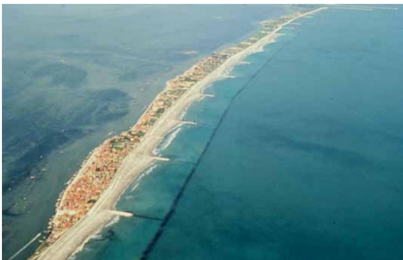
Figura 22 – Vista complessiva delle difese a mare di Pellestrina. Si nota la barriera soffolta
