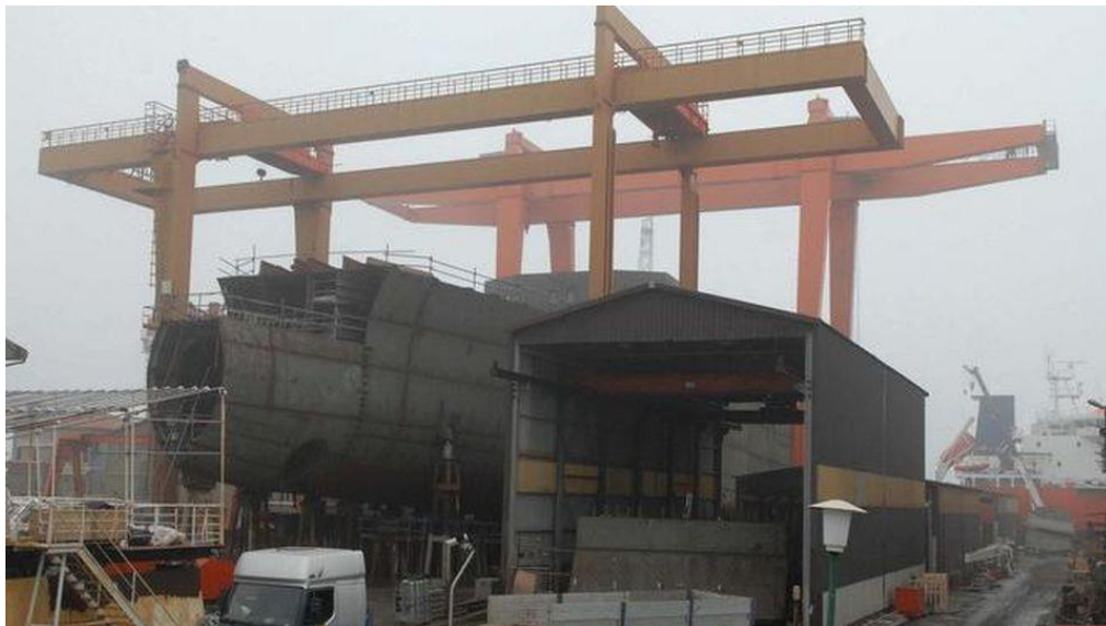
Figura 29 – Vista interna del cantiere durante la gestione De Poli: si noti l’enorme scafo in costruzione (fonte: La Nuova del 03.11.2012, immagine di repertorio)
