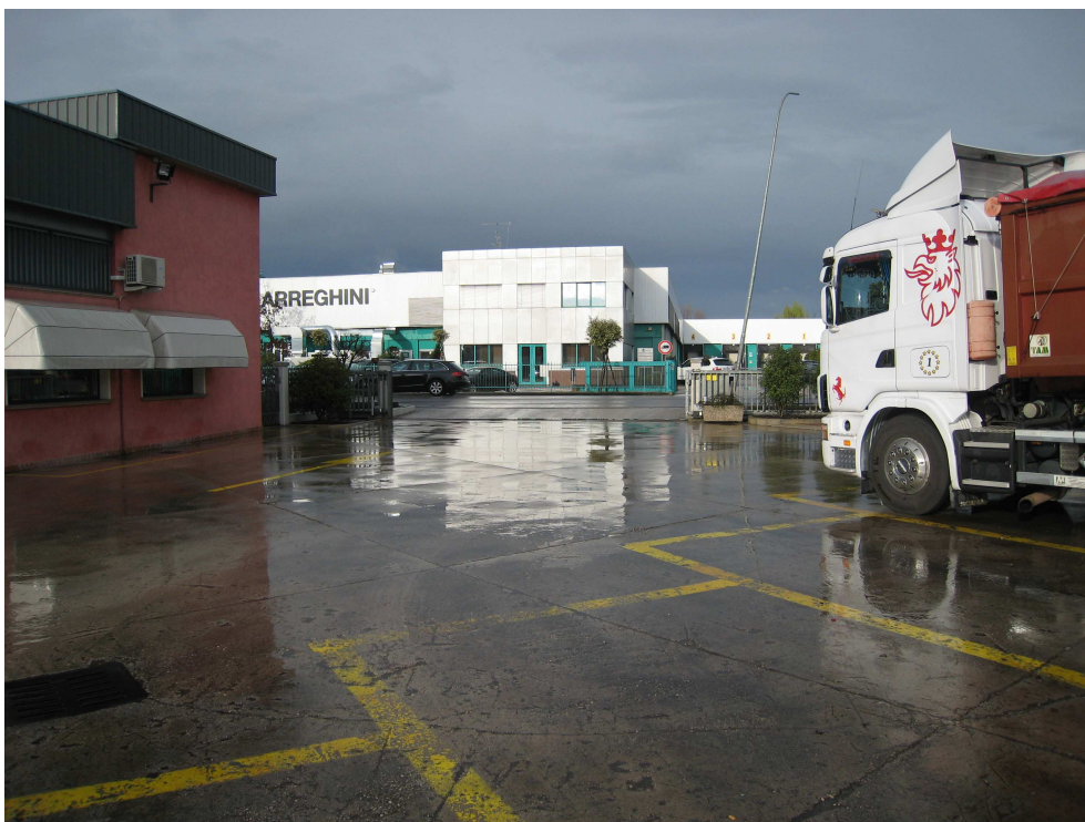
Foto 2 – vista uscita impianto con cancello scorrevole.
