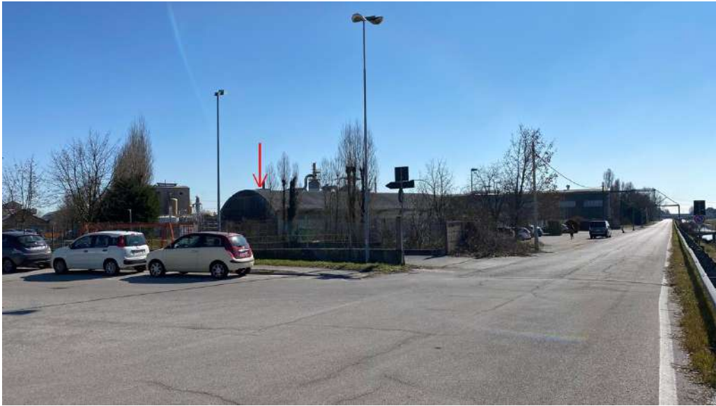
Fig. 49 – Posizionamento dello scrubber dal fiume – argine occidentale
