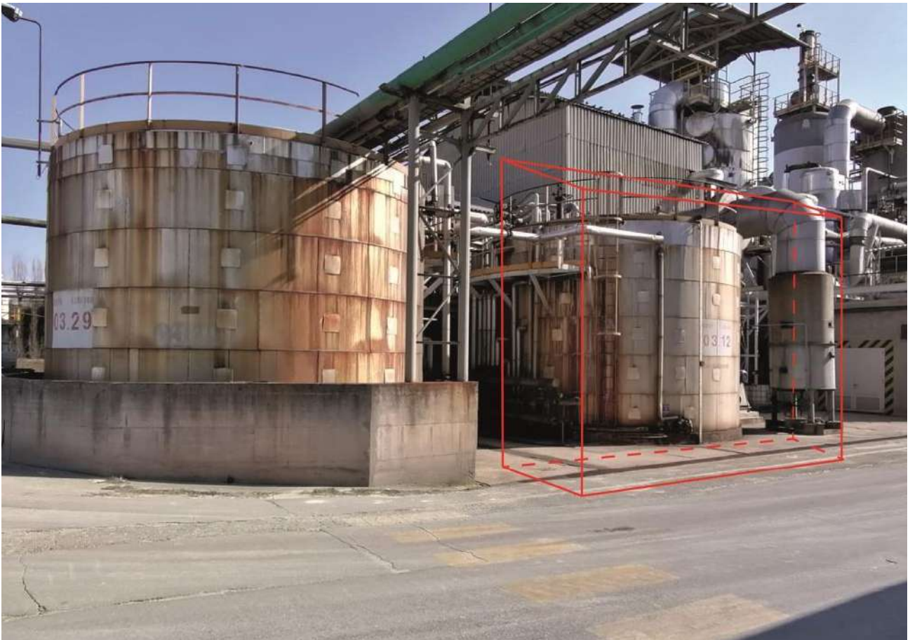
Fig. 26 - Nuova baia di carico (vista da Sud)
