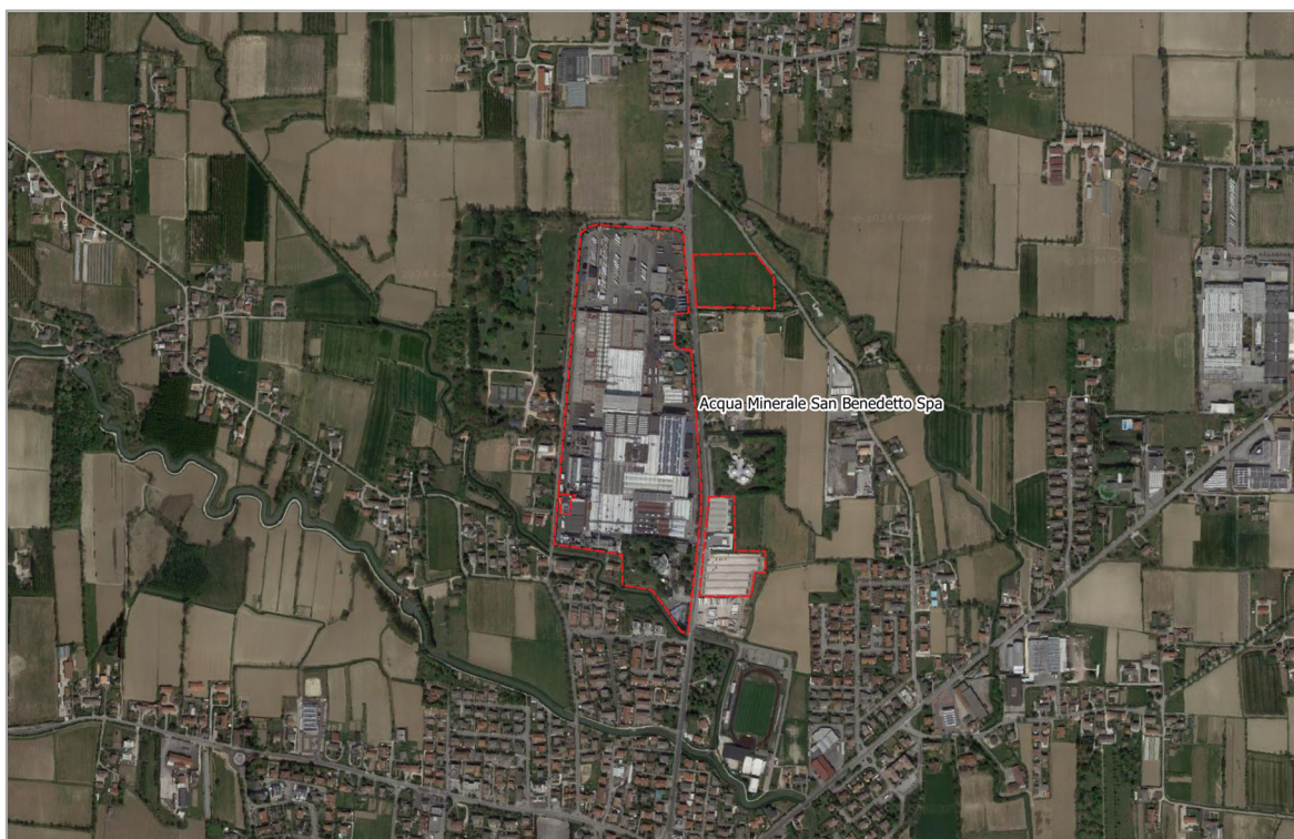
Figura 2.2 Fotografia aerea dell'area dello stabilimento (fonte: Google Earth Pro)
