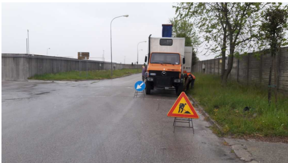
Esecuzione prova CPTU FB con preforo su asfalto.
