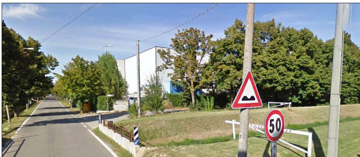
Figura 4.17 Vista angolo Sud-Ovest verso Nord
