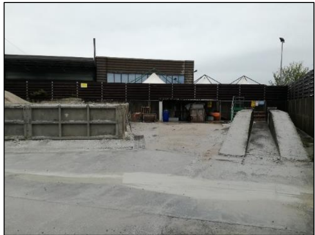
Fig. 2: Deposito temporaneo e rampe manutenzione mezzi
