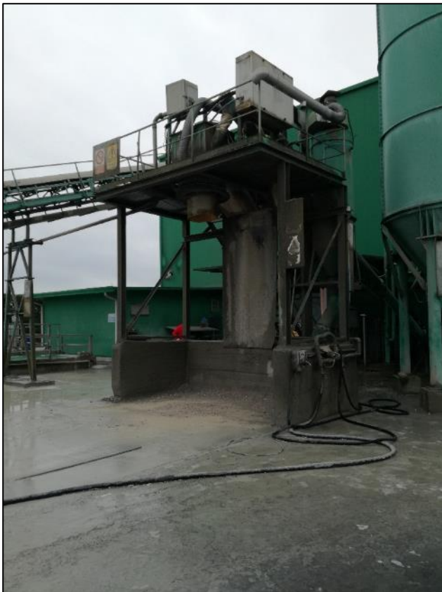
Fig. 9: Bocca di carico mezzo
