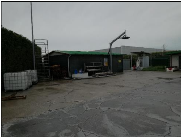
Fig. 3: Polistirolo: deposito e impianto dosaggio
