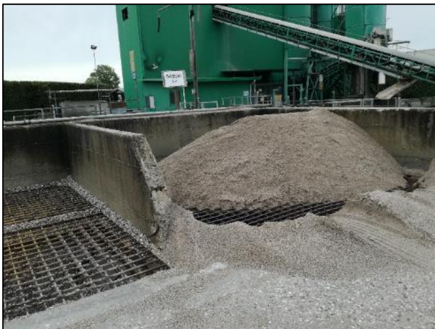
Fig. 5: Rampa carico inerti su tramogge
