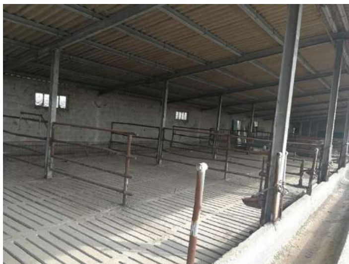
Foto 3. Vista stalla n. 5 da ristrutturare con pavimento in grigliato da bovini
