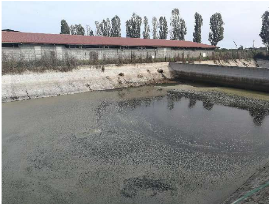
Foto 4. Vista della vasca di stoccaggio dei liquami
