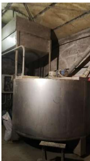
Foto 5 .Vasca in acciaio inox per la preparazione della broda su celle di carico
