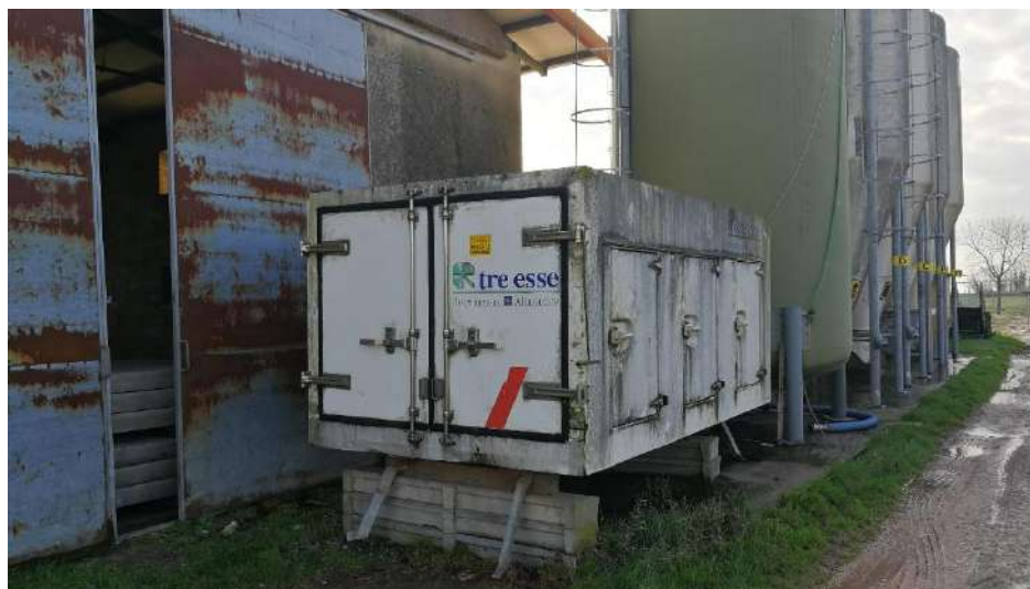
Foto 18. Cella frigo di stoccaggio delle carcasse
