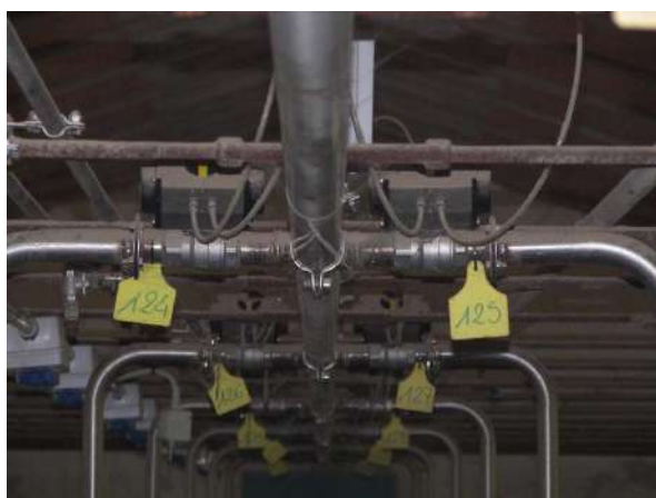
Foto 7. Elettrovalvole numerate di distribuzione della broda per ogni singolo box
