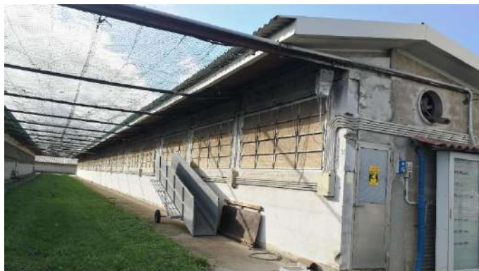
Foto 10: finestratura con argano e cremagliera di apertura
