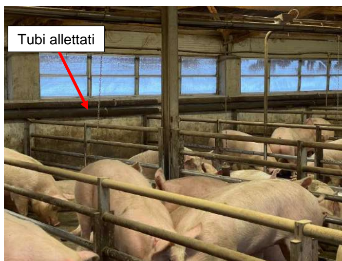
Foto14 Tubo allettato per il riscaldamento delle stalle
