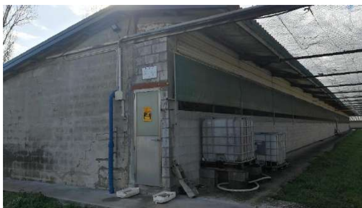
Foto 11. Finestratura con telo in PVC con apertura manuale nel capannone 4
