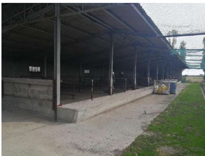
Foto 2. Vista della stalla n. 5 da ristrutturare con mangiatoia
