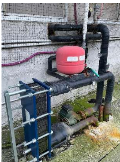
Foto 13 Scambiatore di calore
