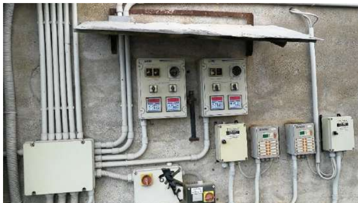
Foto 9: Quadro comandi con rilevatore della temperatura interna capannone 3
