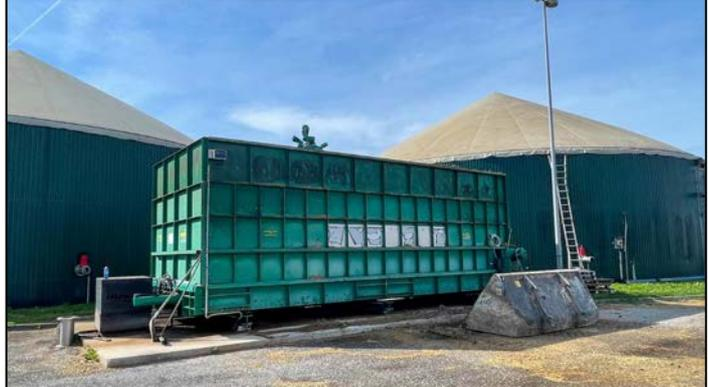
*Fotografia della tramoggia di carico degli insilati già installata e attiva sull'impianto esistente L0*
