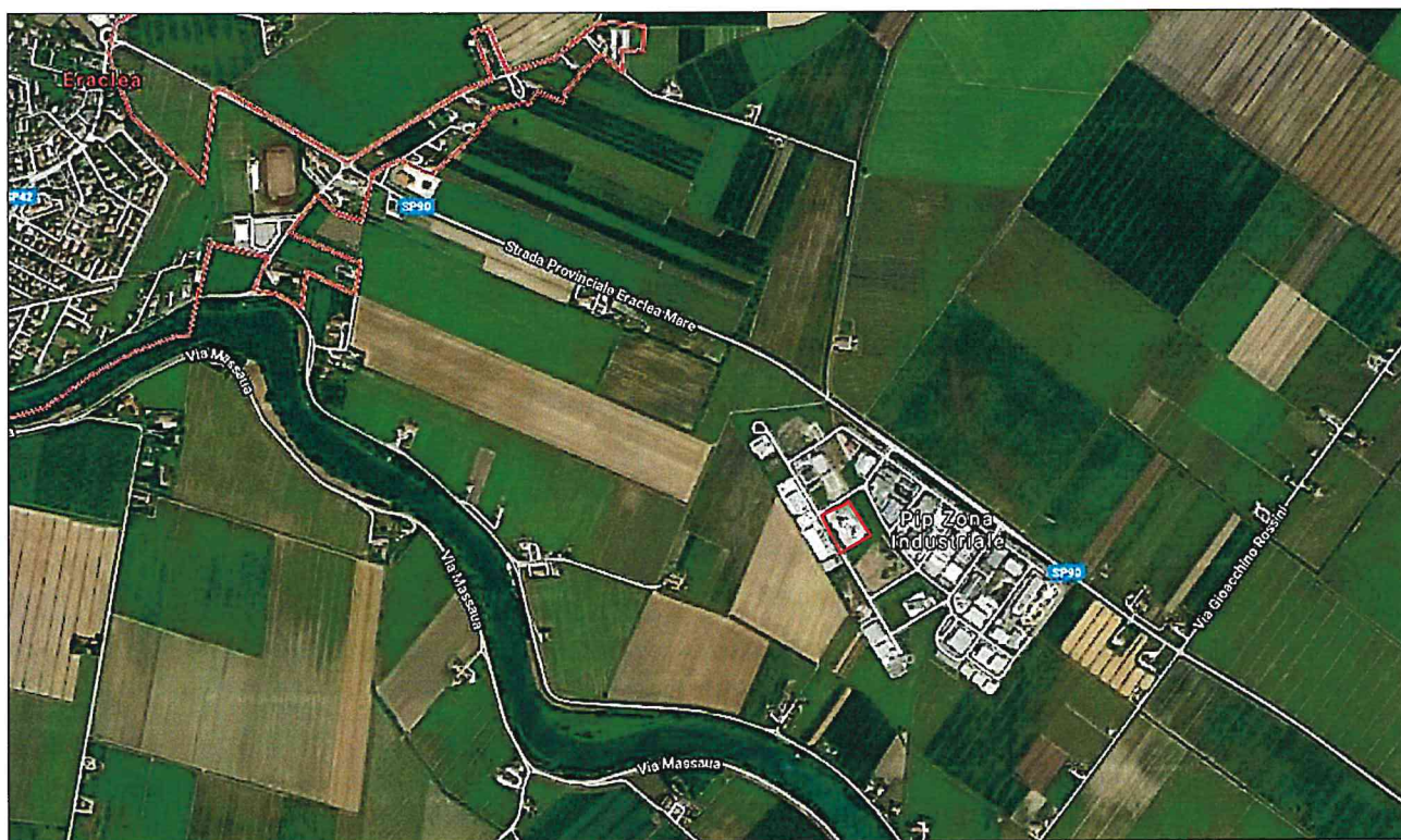
Figura 1 – Localizzazione impianto General Beton Triveneta SpA
