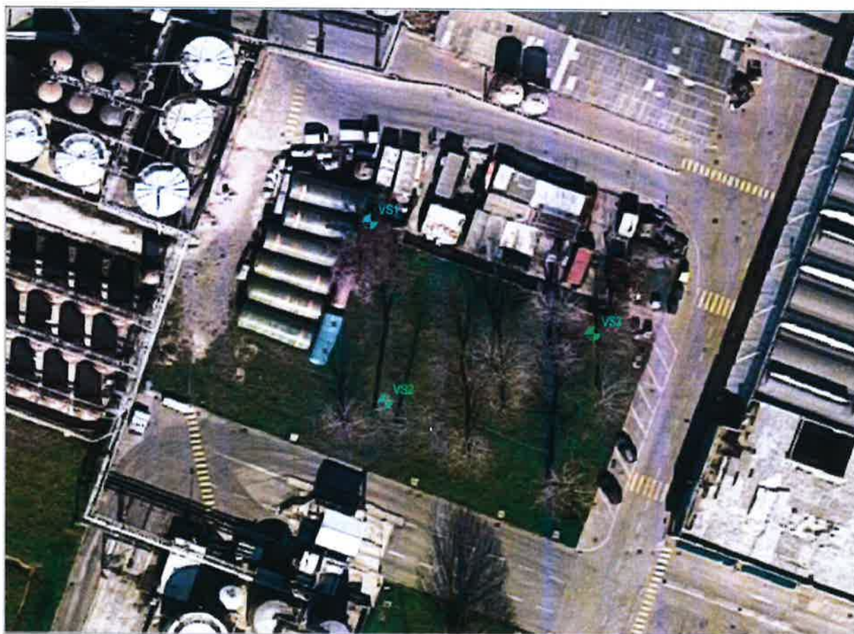
Fig. 5 Dettaglio dell'area con evidenziati i punti dei sondaggi.
