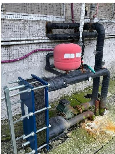
Foto 13 Scambiatore di calore
