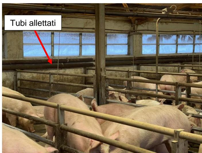
Foto14 Tubo allettato per il riscaldamento delle stalle
