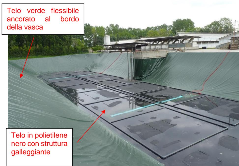
Fig. 70 Telo ad esempio di quello previsto in installazione
