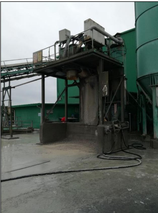
Fig. 9: Bocca di carico mezzo
