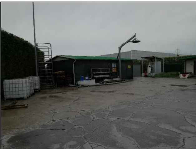
Fig. 3: Polistirolo: deposito e impianto dosaggio
