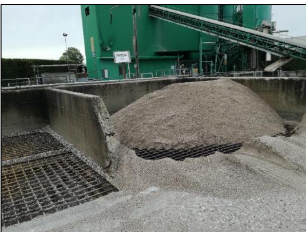
Fig. 5: Rampa carico inerti su tramogge
