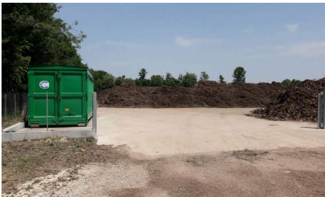
Foto 10 – Vista dell'ingresso all'impianto con sulla sinistra cassone per rifiuti prodotti e sulla destra area messa in riserva.
