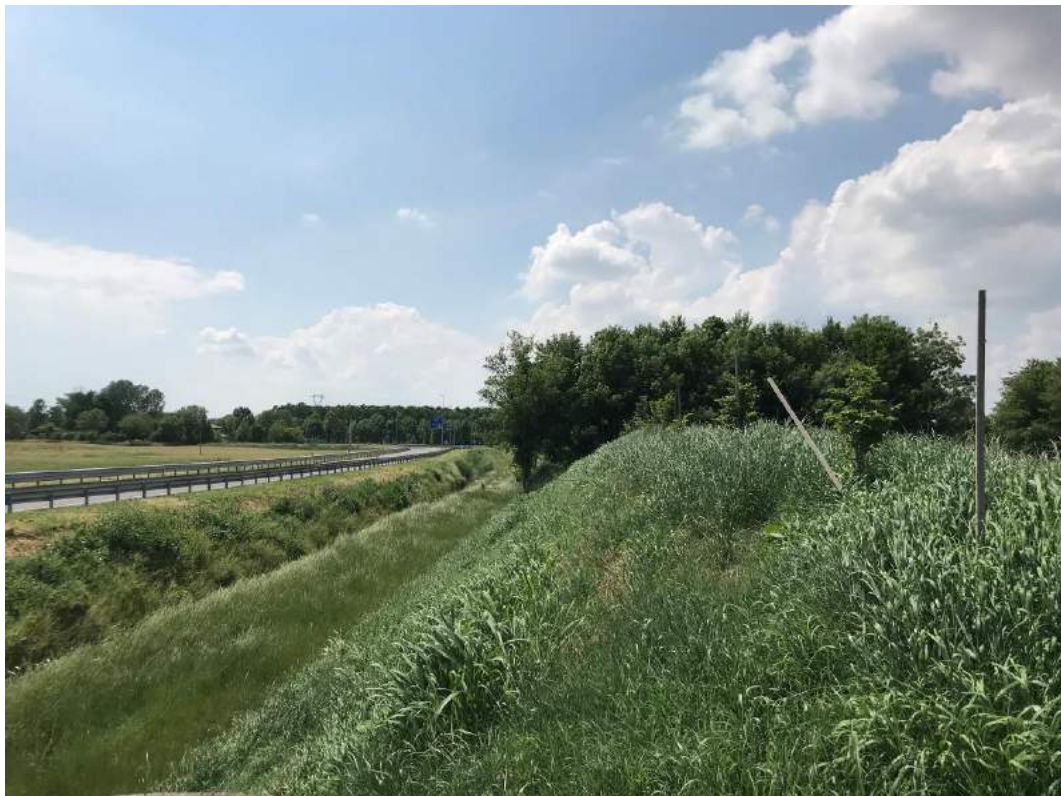
Foto 12 – Vista della S.R. 245 Variante dal Dosso sul lato Sud.
