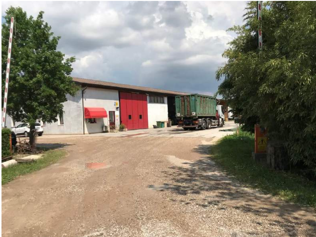
Foto 3 – Vista dell'ingresso all'impianto.
