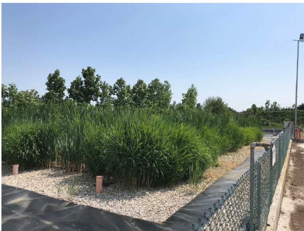
Foto 9 – II° stadio fitodepurazione a flusso sub-superficiale.
