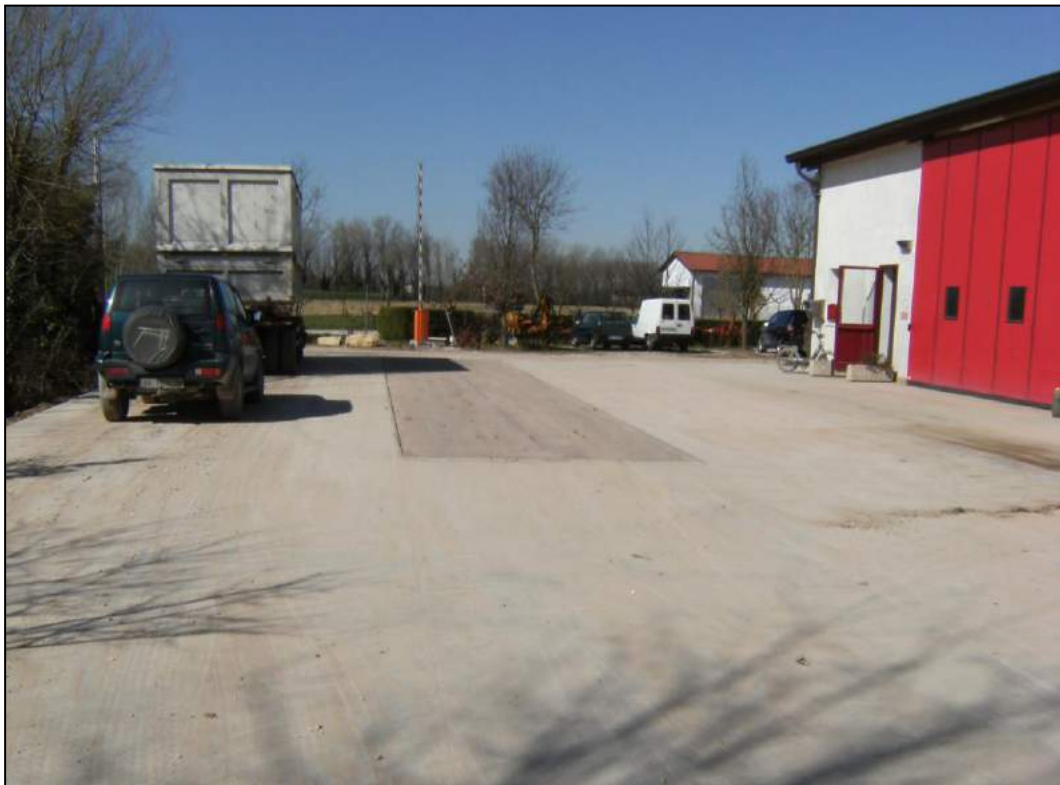
Foto 4 – Vista della pesa all'ingresso dell'impianto.
