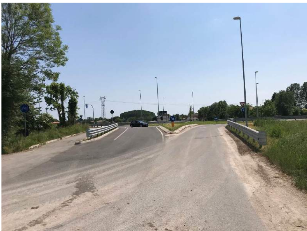
Foto 2 – Vista dall'ingresso all'impianto verso Via San Paolo.
