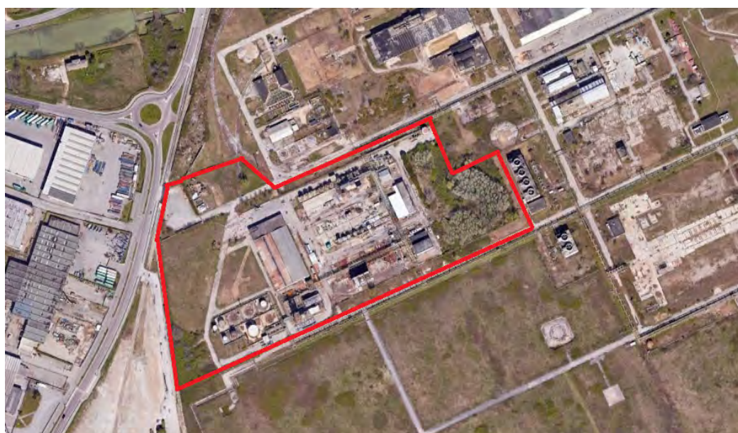
Fig. 2.2 – Ubicazione del sito (Fonte Google Earth); in rosso l'area dello stabilimento
