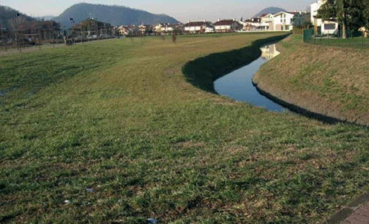
Figura 1: area verde a temporaneo allagamento realizzata ad Abano Terme (Padova) a seguito del parere del Consorzio di bonifica.
