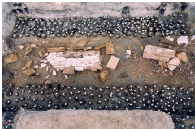
Fig. 2.5 - Roncade (TV), tenuta di Ca' Tron. Saggio 7. I resti del ponte datato all'età del Bronzo Finale (IX secolo a.C.) sul tracciato della via Annia (BUSANA & GHEDINI, 2004). Particolare della fondazione in pali di quercia.
