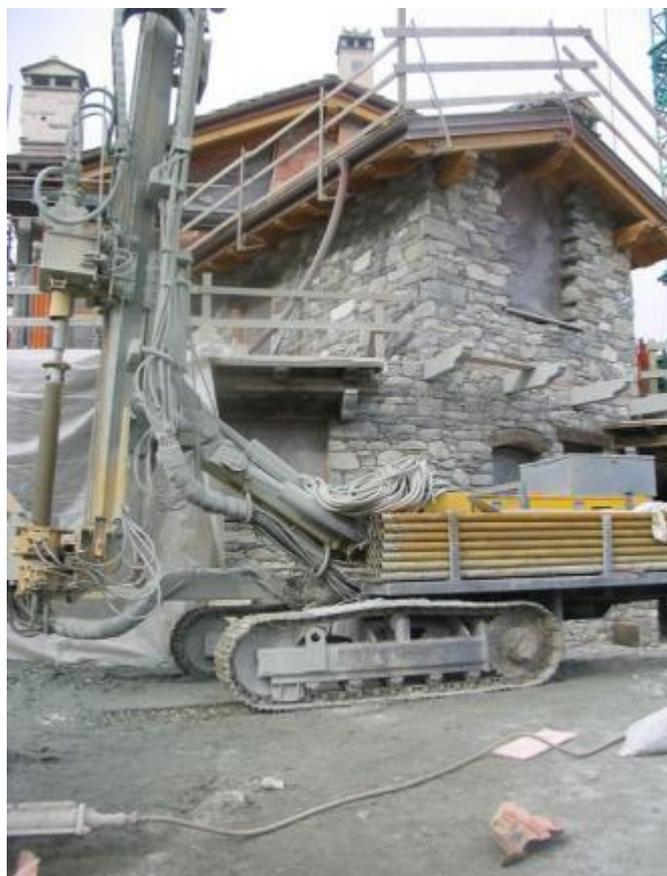
**Perforazione con doppia batteria con rivestimento in avanzamento**
