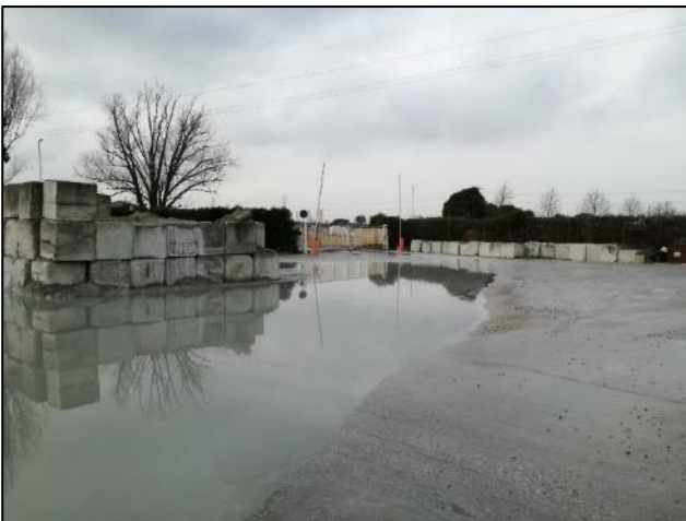
Fig. 13: Dettaglio Piazzale e varco uscita mezzi
