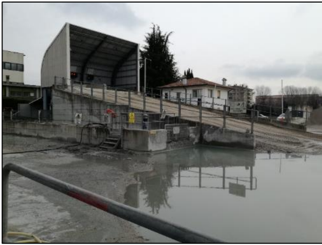
Fig. 7: Rampa carico inerti su tramogge
