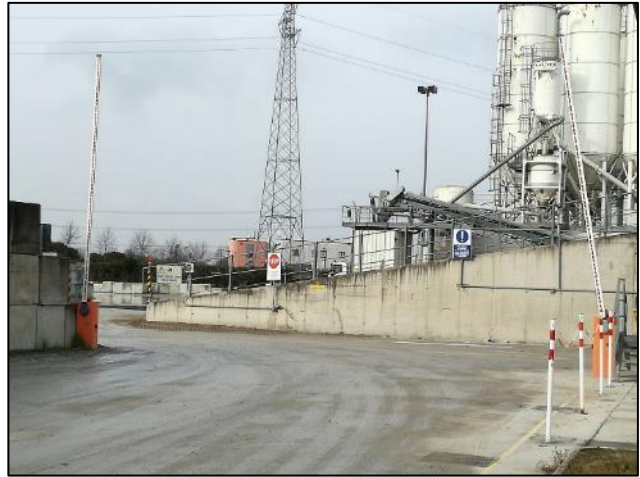
Fig. 4: Vista impianto da ingresso mezzi
