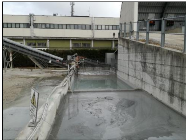
Fig. 10: Vasche accumulo acque meteoriche di dilavamento
